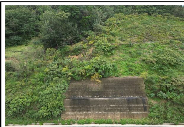
기대기식 옹벽 전경
