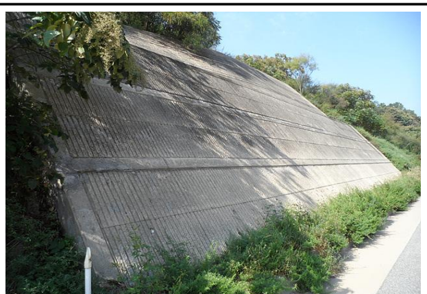
기대기식 옹벽 전경
